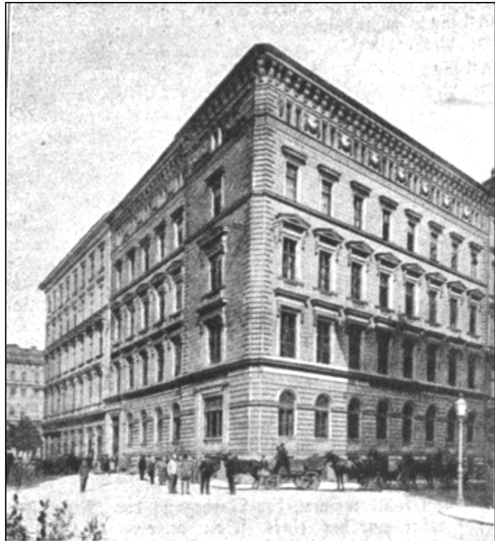
NFP building Vienna, 1904, Fichtegasse in central Vienna.
